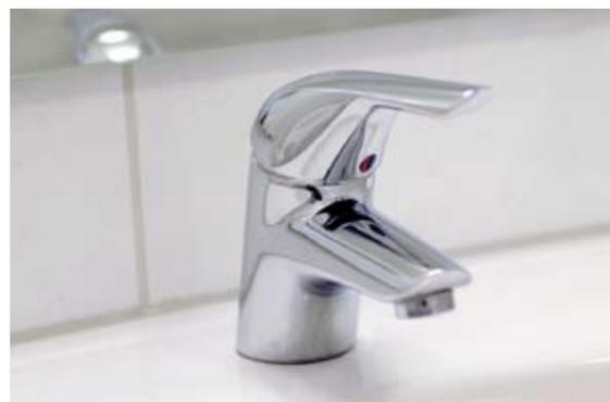
Einhebelmischarmaturen erleichtern die einhändige Bedienung.
