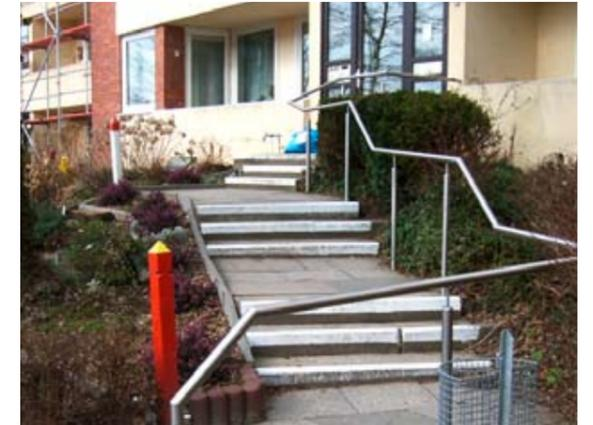
Vorher: Stufen zum Hauseingang mit Stufenkantenunterschneidungen.
