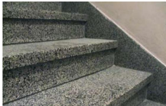
Stufenkantenunterschneidungen sind gefährliche Stolperfallen.
